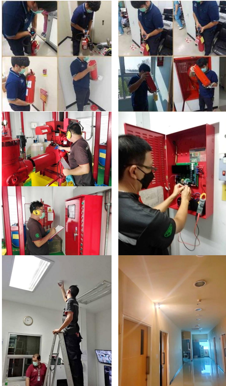
รูปที่ 2-43 การตรวจสอบดูแลรักษาอุปกรณ์ป้องกัน/เตือนภัยอัคคีภัย
