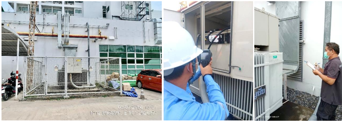
รูปที่ 2-33 การตรวจสอบหม้อแปลง ขนาด 2,000 KVA ของโครงการ
