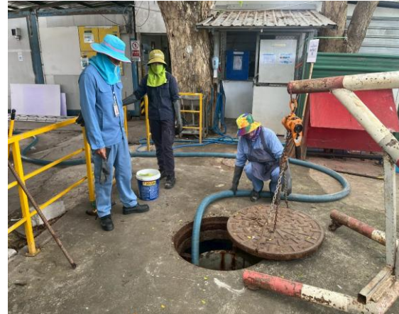
รูปที่ 2-12 เทศบาลตำบลเชิงเนินเข้ามาสูบตะกอนระบบบำบัดน้ำเสีย
