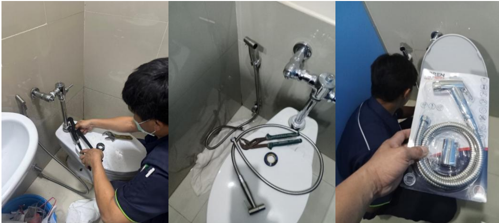
รูปที่ 2-37 ตรวจสอบและซ่อมแซมระบบจ่ายน้ำประปาภายในโครงการ
