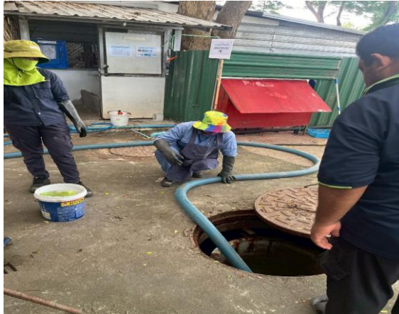
รูปที่ 2-12 เทศบาลตำบลเชิงเนินเข้ามาสูบตะกอนระบบบำบัดน้ำเสีย
