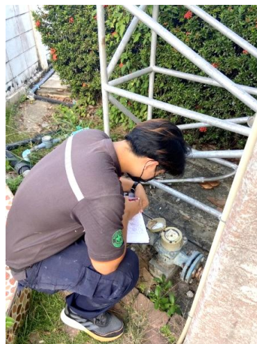
รูปที่ 2-40 การตรวจเช็คมิเตอร์น้ำและจุดบันทึกปริมาณการใช้น้ำเป็นประจำ
