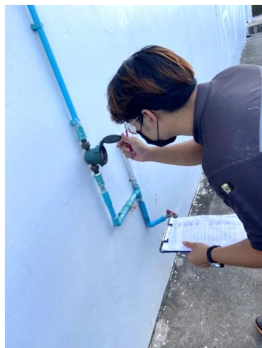
รูปที่ 2-40 การตรวจเช็คมิเตอร์น้ำและจุดบันทึกปริมาณการใช้น้ำเป็นประจำ
